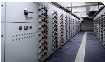
重要機器の継続的モニタリング
