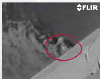
熱画像上ではっきりと見えるガス漏れ
